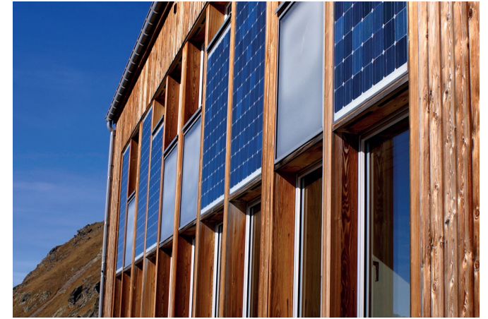
Panneaux photovoltaïques et isolation thermique transparente
