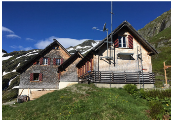
Gesamtsanierung / Erweiterung Gaulihütte
