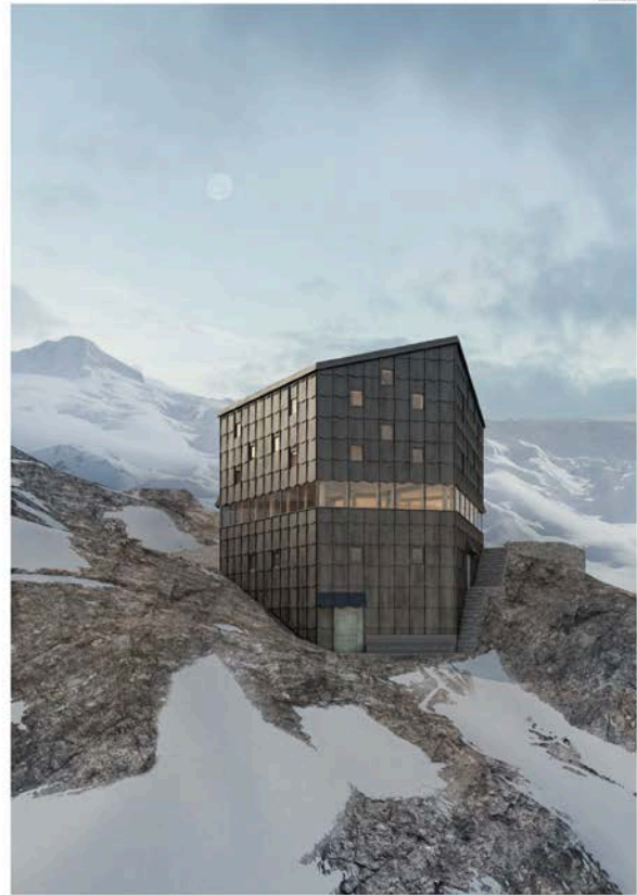
Erscheinung des rechteckigen Schutzhüttes in der Fels- und Gletscherlandschaft
