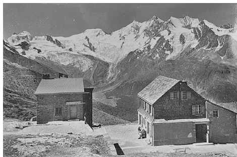
Abb. Links neue Hütte 1960, rechts alte Hütte saniert
