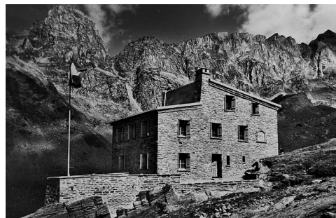
Abb. Neue Hütte 1960 Südwestseite
