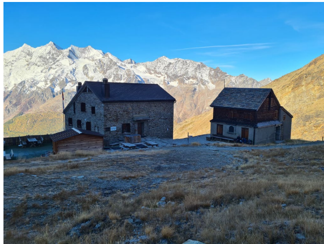
Abb. Hütten heute nordostseitig
